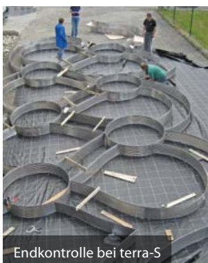
Aufbau der Profile auf der Baustelle
