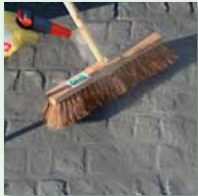
Erhärten des Mörtels auf der Oberfläche vermeiden
