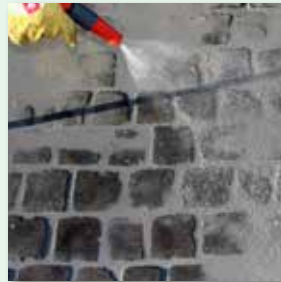
diagonal zur Fuge abreinigen
